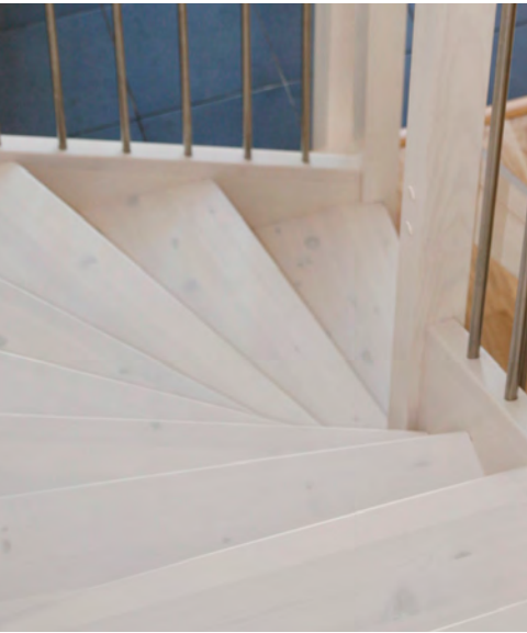
Tät trappa i vitlaserad och lackad furu. Handledare och räcke i vitlaserad furu, typ Funk 11 (spjälkor av metall)
